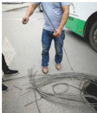
市政施工 暴力扯断
